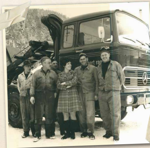
Loni Mussmann mit einem Teil der Beleg- schaft und dem ersten LKW mit Abrollcontainer 1972
